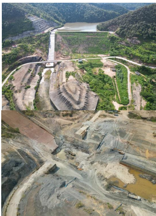
รูปที่ 1.6-2 ความก้าวหน้าการก่อสร้าง บริเวณ Stilling Basin ของอาคารระบายน้ำล้น (Spillways)
